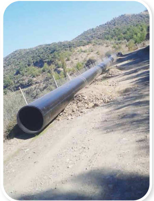
HER ÇAPTA HDPE (PE100) ALIN KAYNAK İMALATI ve MONTAJI
