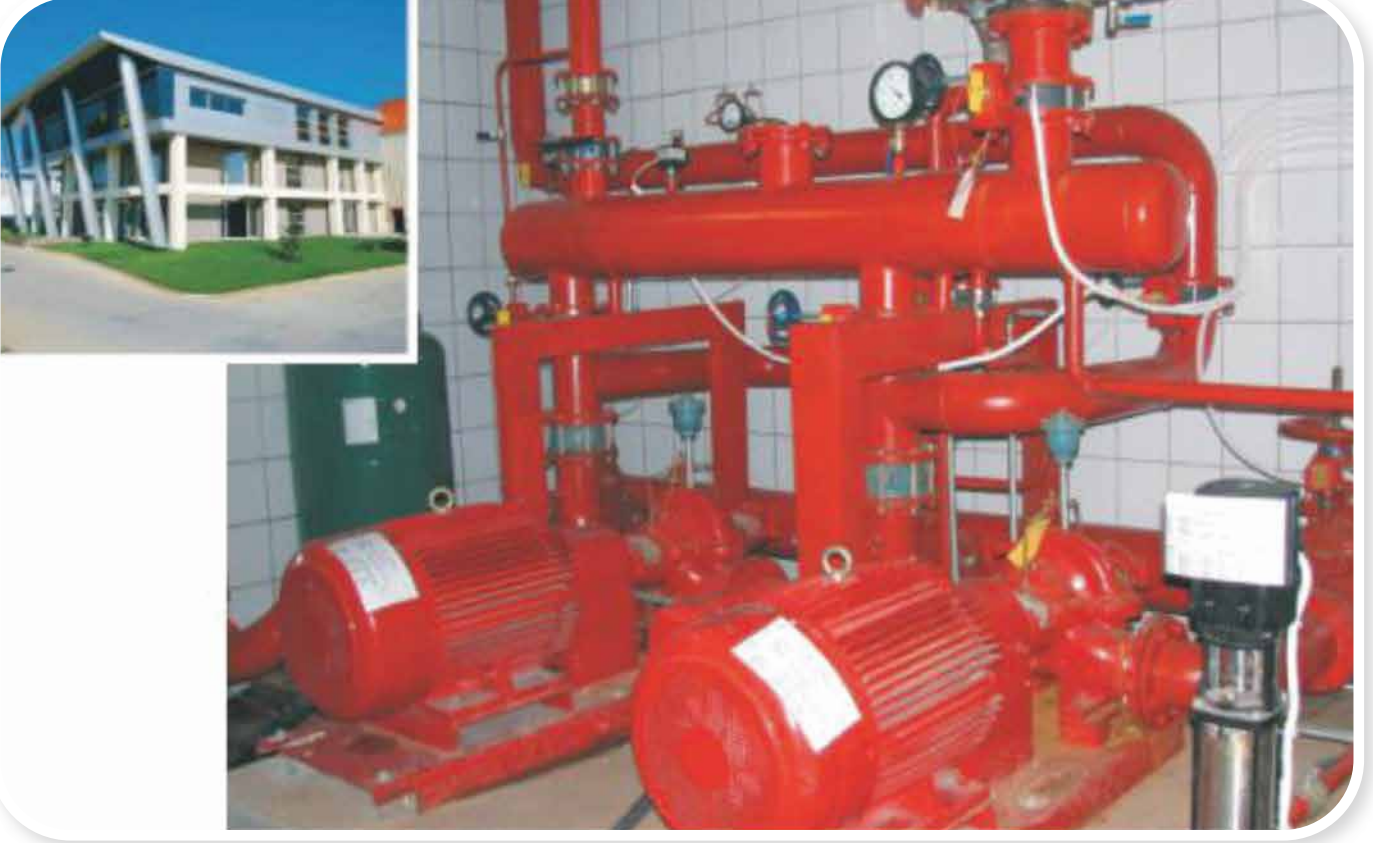
FABRİKA POMPA BİNASI - POMPA İMALATI ve MONTAJI
