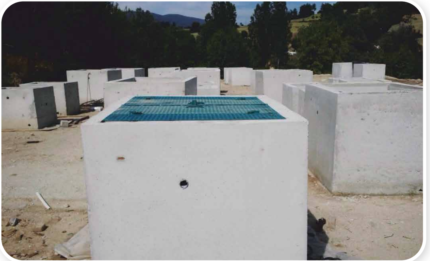
SANAT YAPILARI BETONARME ve SAC KAPAK İMALATI
