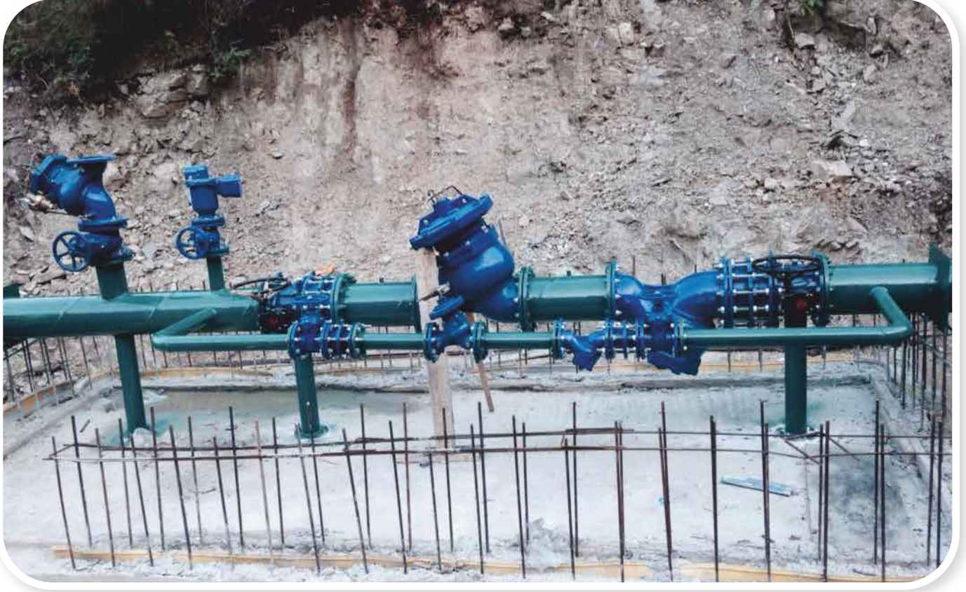
DENİZLİ - DIMBAZLAR SULAMASI - BASIN KIRICI İMALATI ve MONTAJI
