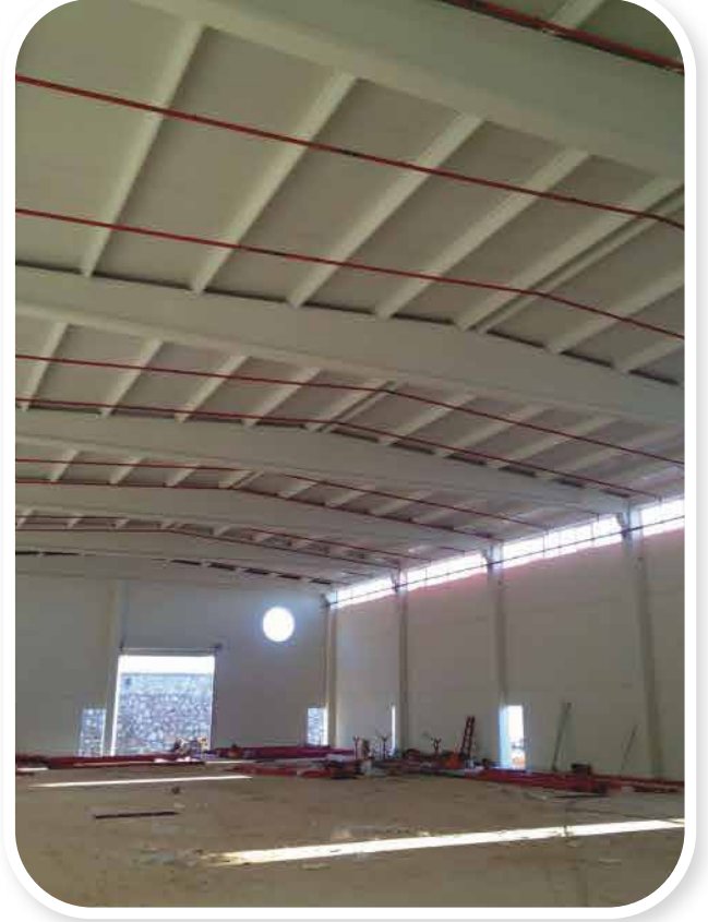
FABRİKALARIN YANGIN SİSTEMLERİ ve YANGIN SPRİNGLERİ MONTAJI
